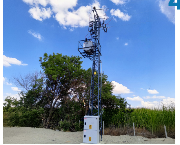
AG-OG YERALTI VE HAVAİ HAT ÇALIŞMALARIMIZ
